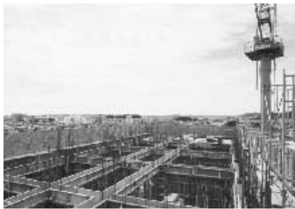
近隣家屋へ十分な注意が払われている工事現場
