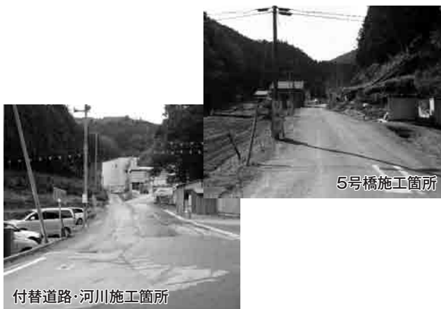
付替道路・河川施工箇所
