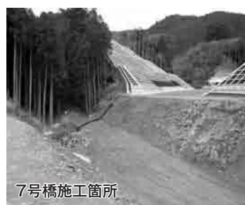
7号橋施工箇所
