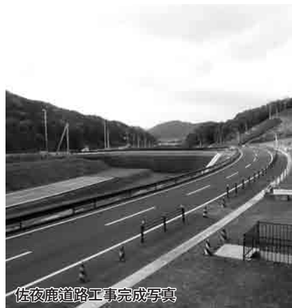
佐夜鹿道路工事完成写真
