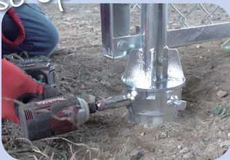
④支柱はボルト4本で基礎に取り付けます。
