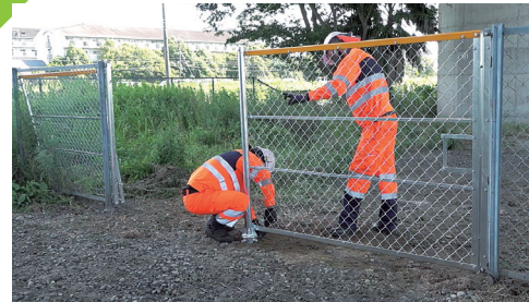
②基礎に止めた支柱を外します。
